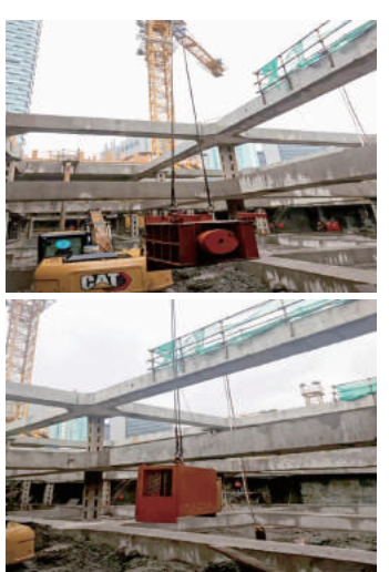
设备吊入基坑
