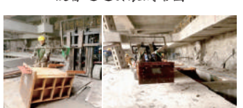
设备运送至安装区域
