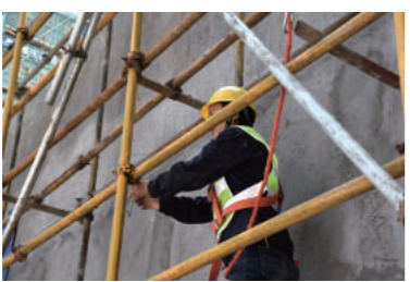
事故抢险组加固架体
